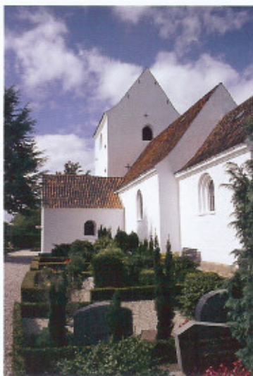
Fra sydøst ses alle kirkens bygningsdele. Vinduerne, der ses i kor og skib var oprindeligt lavere og smallere.
